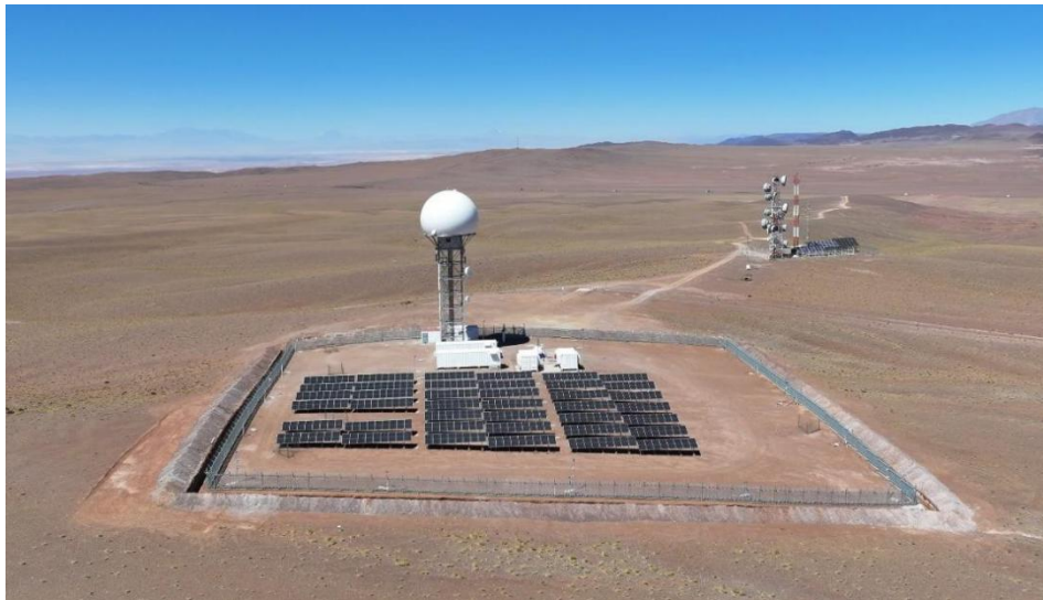
100%由太阳能供电的泰雷兹 STAR NG 和 RSM 组合空管雷达 © Thales
